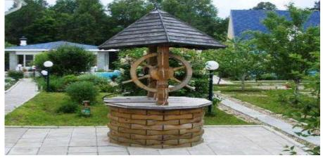
Наземная часть шахтного колодца служит для защиты шахты от засорения и загрязнения и должна быть не менее чем на 0,7-0,8 м выше поверхности земли.
